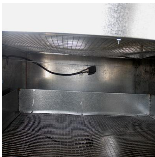
شکل ۳- حس گرهای نصب شده در فضای بین سینی‌ها Fig.3. Sensors mounted in space of between trays
