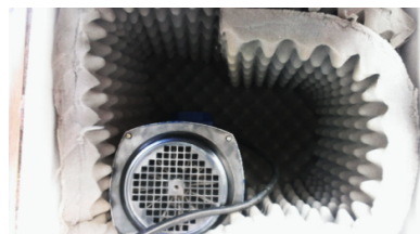
شکل ۶- نمای داخلی اتاقک آکوستیک Fig. 6. Interior acoustic chamber
