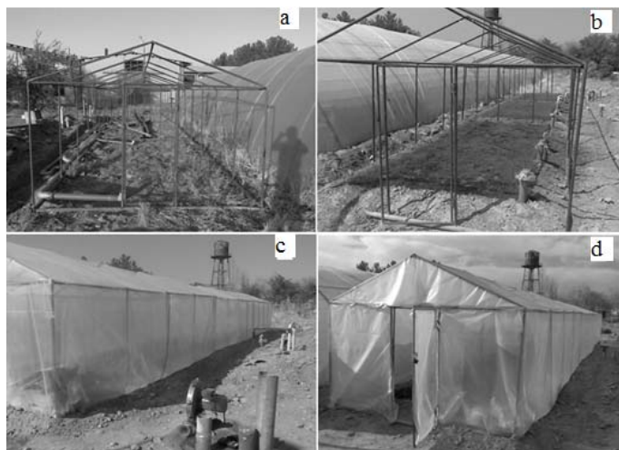
شکل ۲- مراحل ساخت گلخانه: (a) ساخت اسکلت گلخانه. (b) کشت چمن. (c and d) ایجاد پوشش پلاستیکی بر روی اسکلت و تکمیل ساختمان گلخانه
