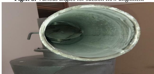
شکل ۱- پ - موقعیت قرارگیری صفحه داخل لوله قسمت خروجی
